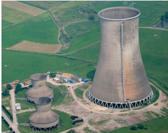
Fig: Cooling tower
