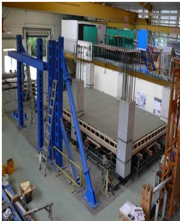
First floor in-situ topping pour complete
